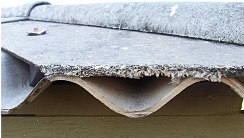
石綿是性質優良的建材，圖為風化後露出鬆散棉絮的石綿板
