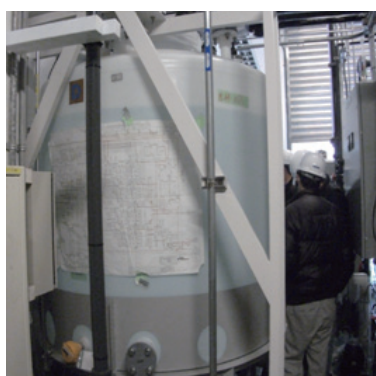
研磨液回收再利用設施
