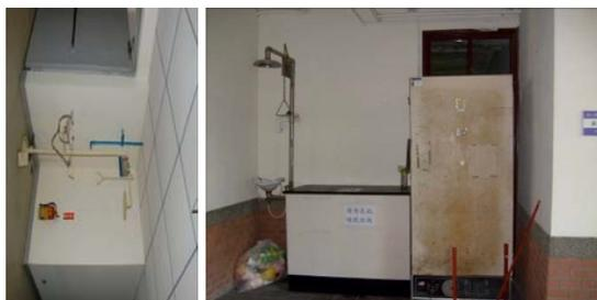
圖十三 (左) 使用單位有維護設備正常與潔淨，及空間不被佔用之責任。(右) 沖眼器、緊急淋浴空間被用最為常見，一旁設置電器時，使用期間將發生漏電風險。
