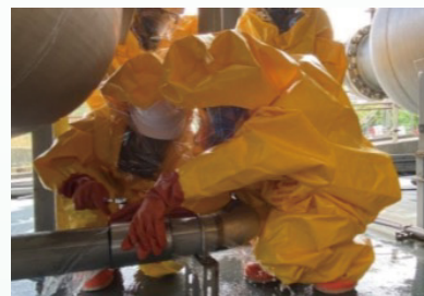
槽車/儲槽/管線洩漏應變實作
