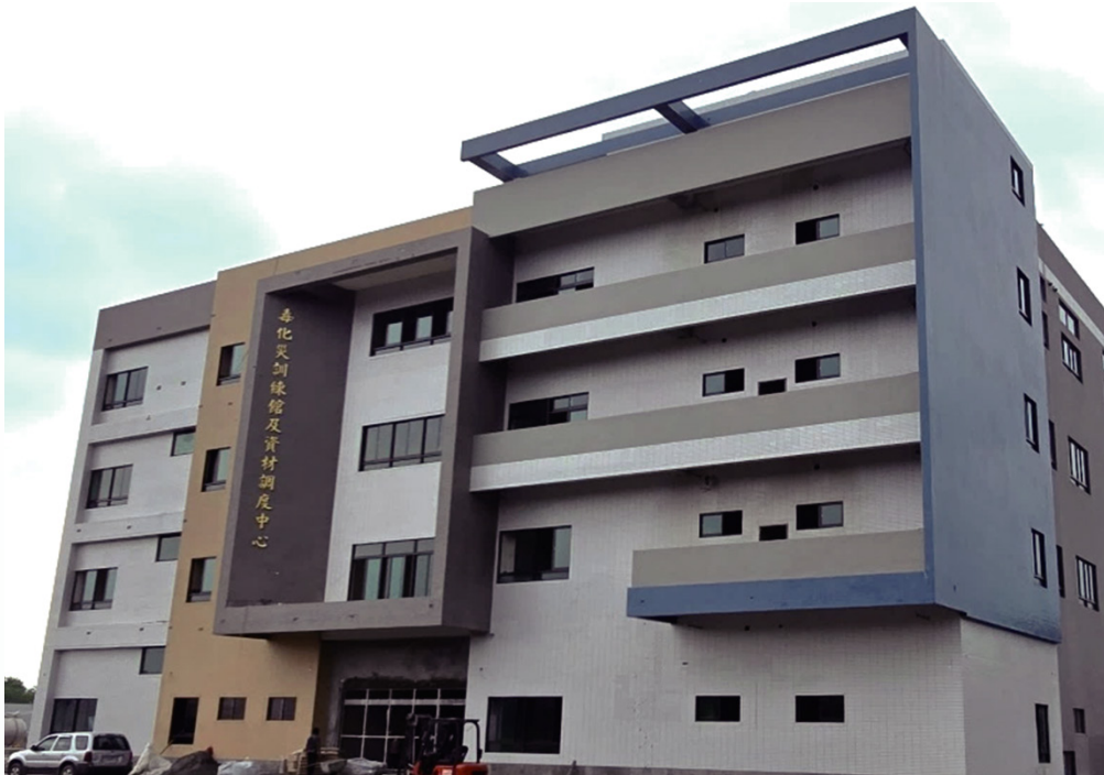
圖 23 中區毒化物災害訓練場興建工程
