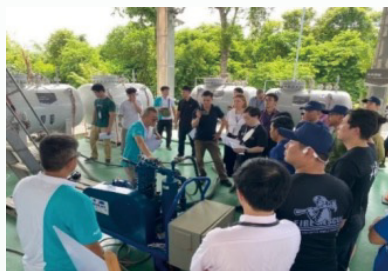
鋼桶、槽車移槽實作
