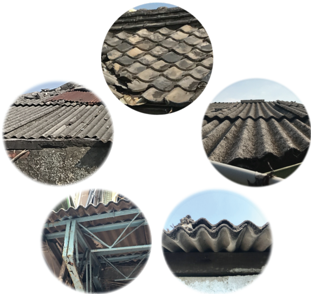
圖：含石綿的屋頂建材—石綿瓦
