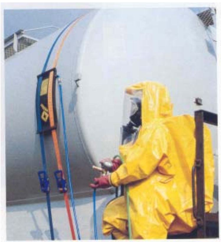
圖3.4.2 1.5BAR 槽車桶槽充氣補漏密封片使用圖
