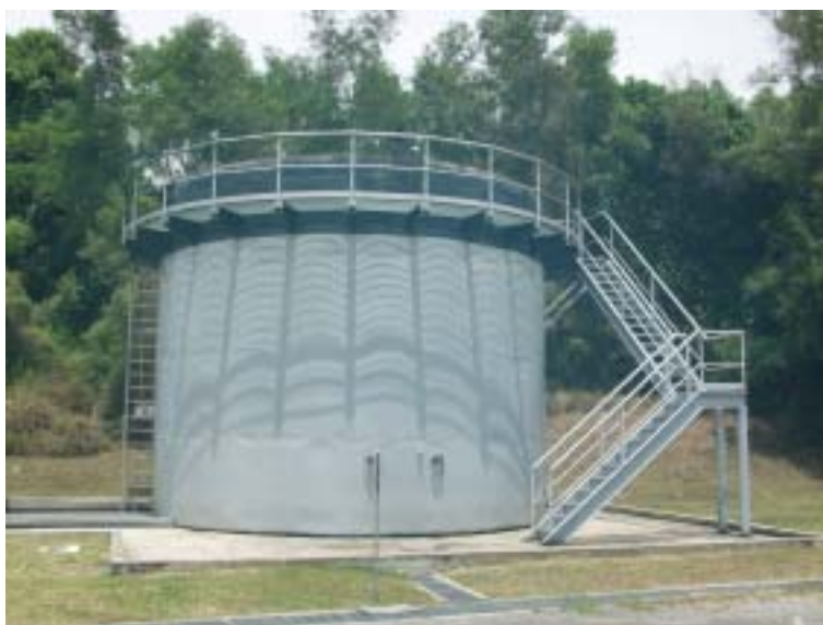
圖4.2.4 儲槽實火訓練的場所
