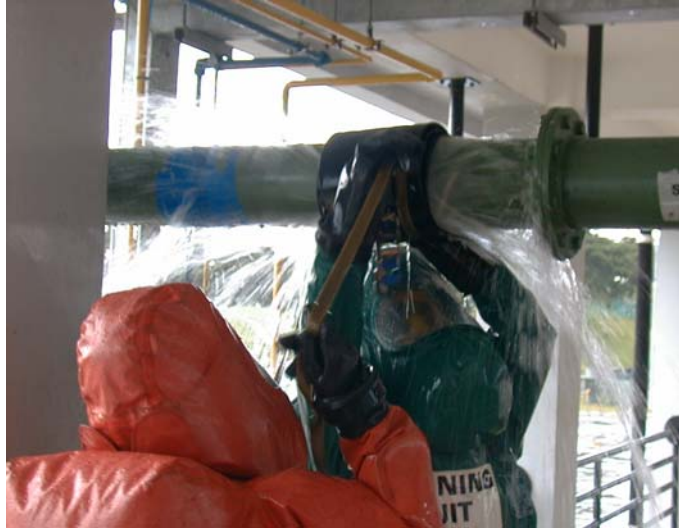
圖 3.1.10 管線洩漏事故訓練圖
