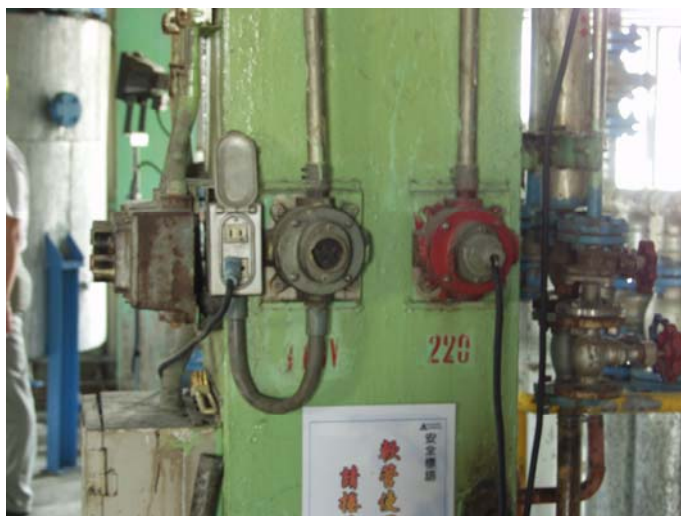
圖一、製程區內使用非防爆型電器設備與插座
