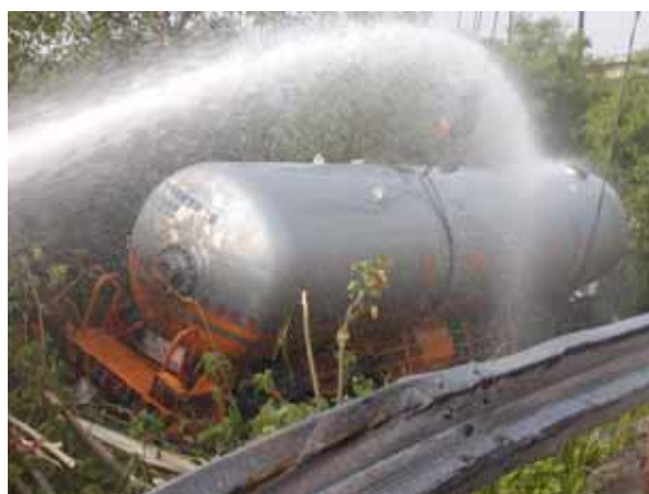
圖 4.3.10 協請現場消防隊以水霧噴灑阻隔可能之引火源
