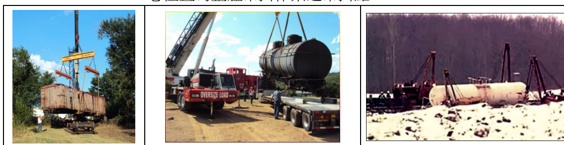
圖 4.3 美國鐵路槽車使用吊車進行扶正與吊離作業
