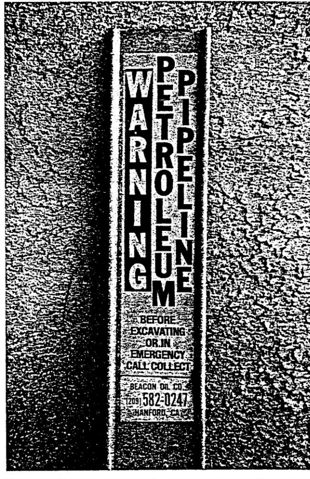
圖 5.20 此管路標記顯示典型的標示資料
