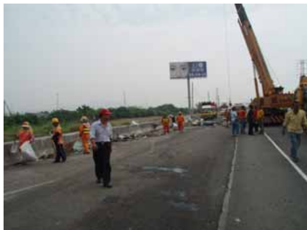
照片 8、現場高公局人員進行地面除污
