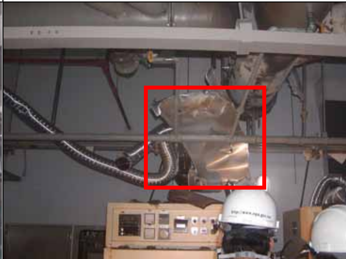
照片 6・爆炸後風管掉落的碎片(二)
