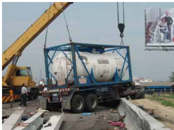
照片 6、吊車進行槽體吊離作業
