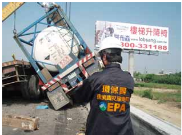
照片 4、應變人員利用檢知管於現場進行偵測
