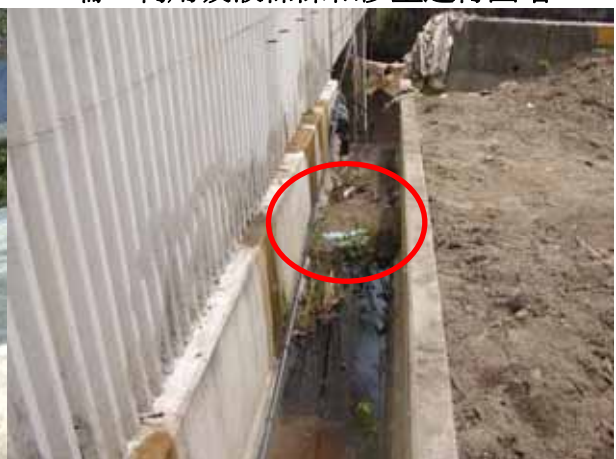
照片6・ 應變隊人員於國道下排水溝的末端，利用吸液棉條和沙土進行圍堵
