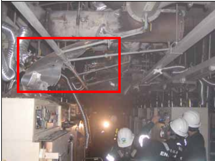
照片 5・爆炸後風管掉落的碎片(一)
