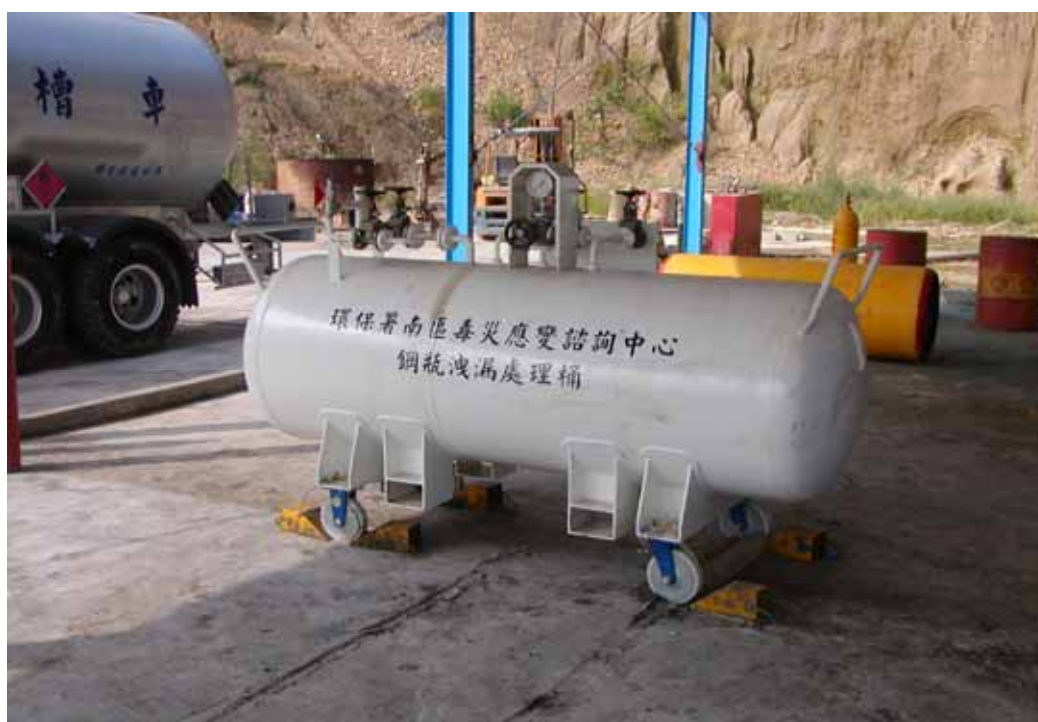
圖 3.1.49、毒災應變實作訓練場_高壓氣體鋼瓶洩漏控制
