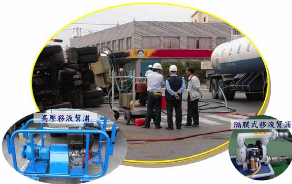
圖 3.1.14、進行槽車移槽處理作業情形
