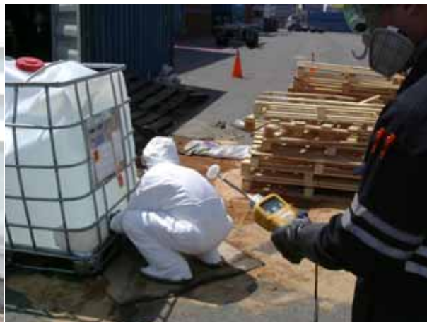
照片10・廠商人員進行破損儲桶止漏之情形
