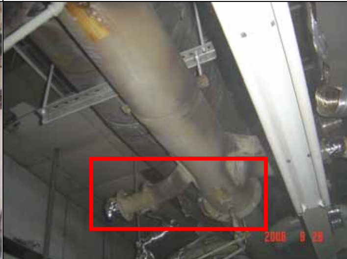
照片 6・爆炸後風管掉落的碎片(二)
