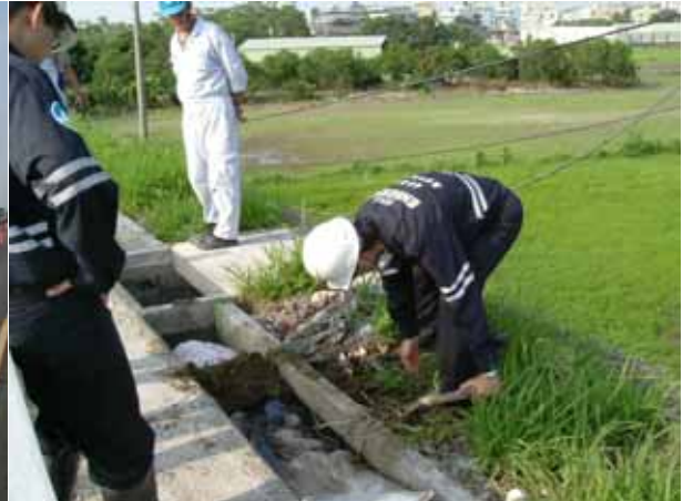
照片6・ 應變隊人員於國道下排水溝的末端，利用吸液棉條和沙土進行圍堵
