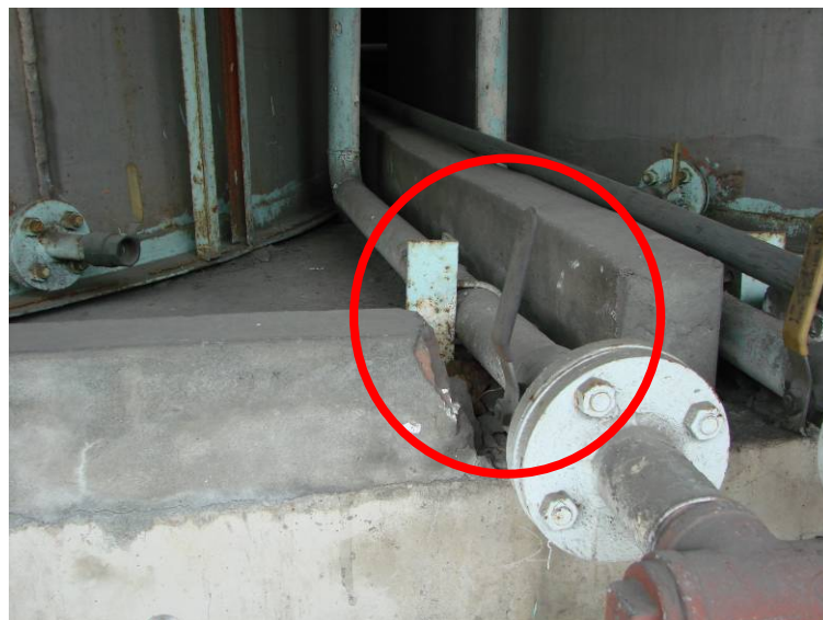
圖七、無防溢堤設計，洩漏液容易擴散
