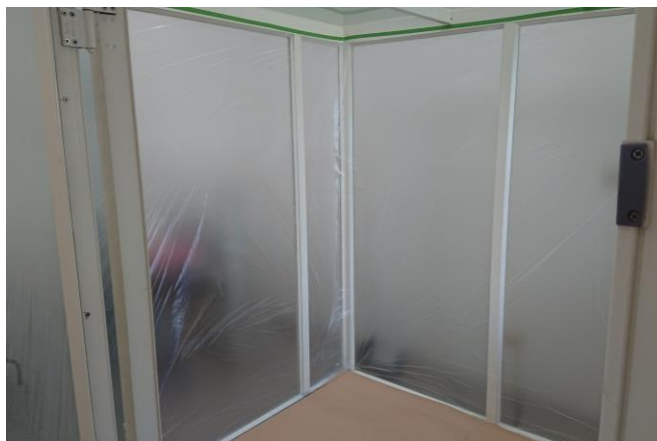
圖 23. 玻璃室底層鋪牛皮紙，四面黏貼防漆遮塵膠布
