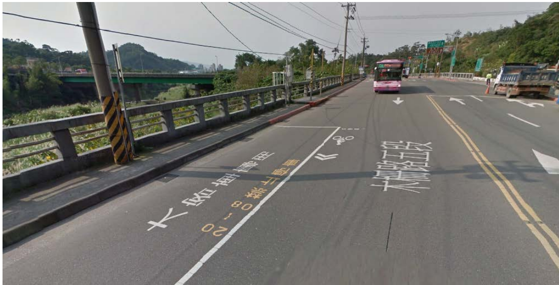
圖 5.3-16 北部抽驗作業現場地點場景
