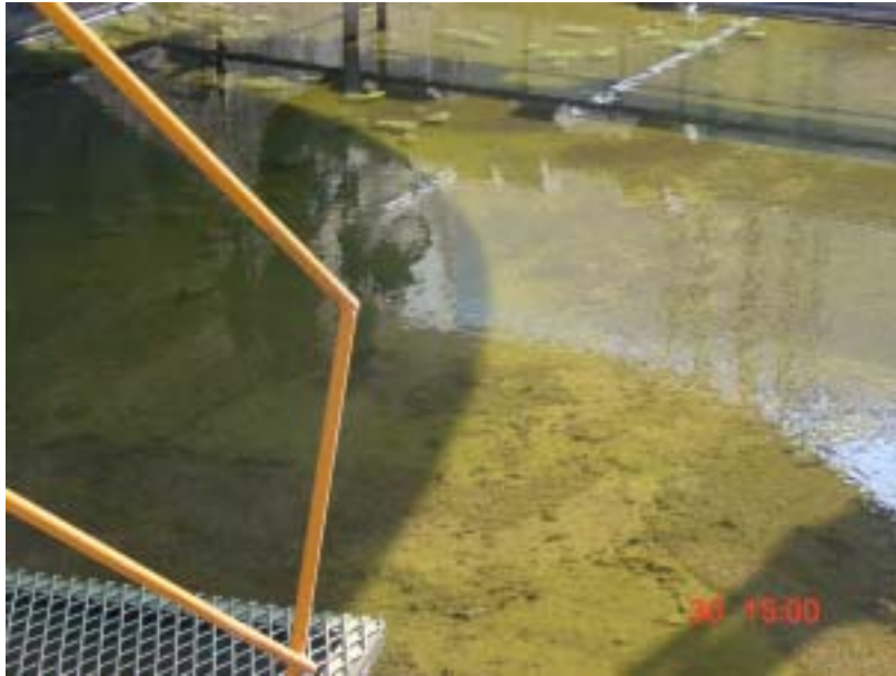
圖二、VCM 防液堤內請加強排水設施之功能
