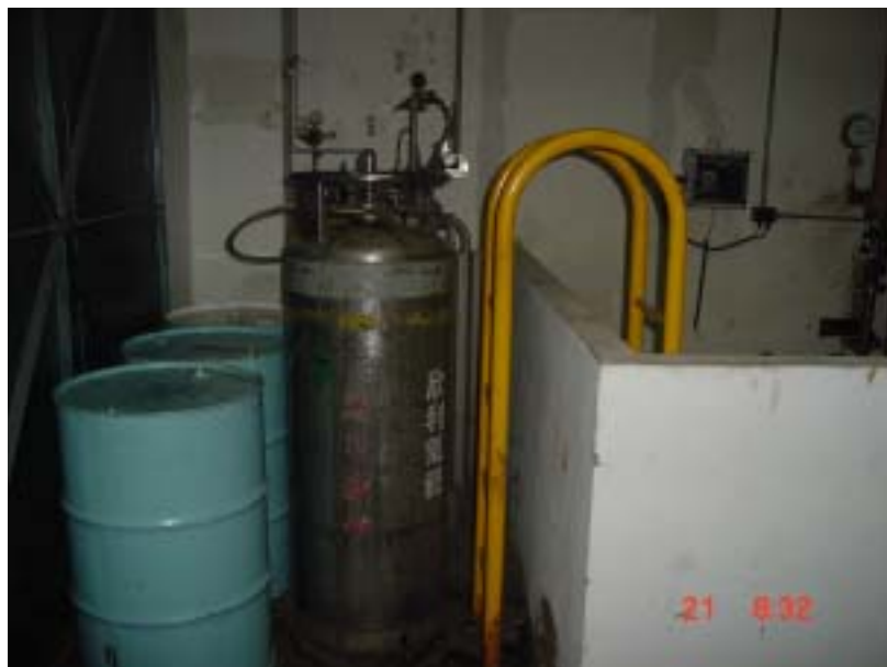
圖二、以氮氣鋼瓶進行氮封避免 TDI 氣體外洩
