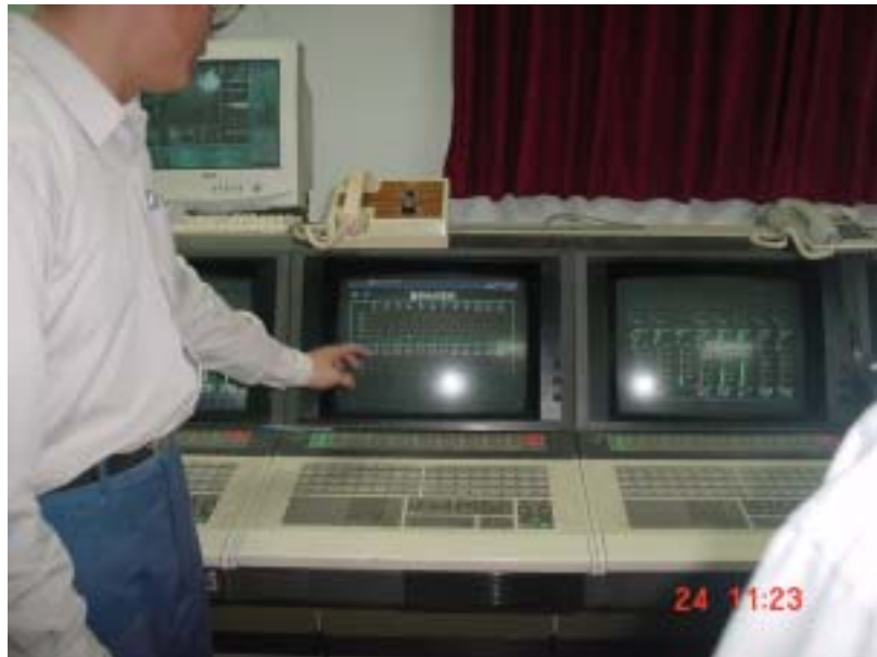
圖三、中央控制室顯示工廠各區氫氣濃度值
