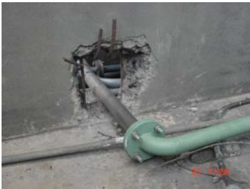
圖三、防液堤內缺口應填補完成
